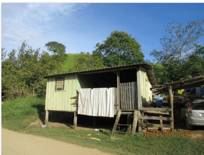
Figura 5: Casa para funcionário.
